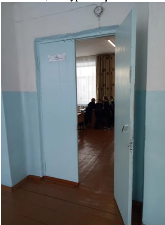
Ф.2. Вид полов и дверного проема в кабинеты.
