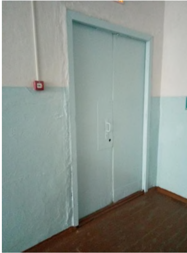
Ф.5. Вид двери на запасную лестницу.
