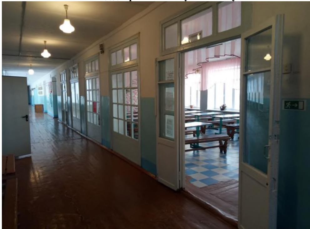
Ф.6. Вид коридора 2 этажа и вход в столовую
