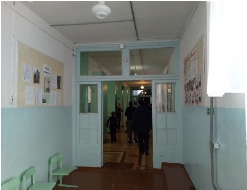
Ф.1. Вид тамбура с первого этажа.
