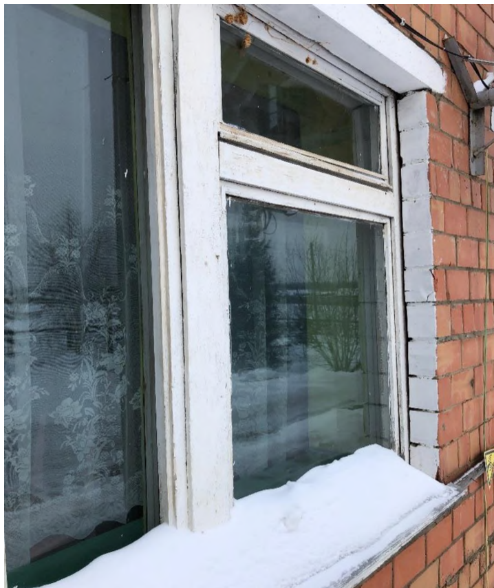
Фото 4. Оконные блоки 1-ого этажа
