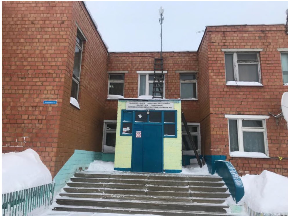
Фото 5. Главный вход в здание.
